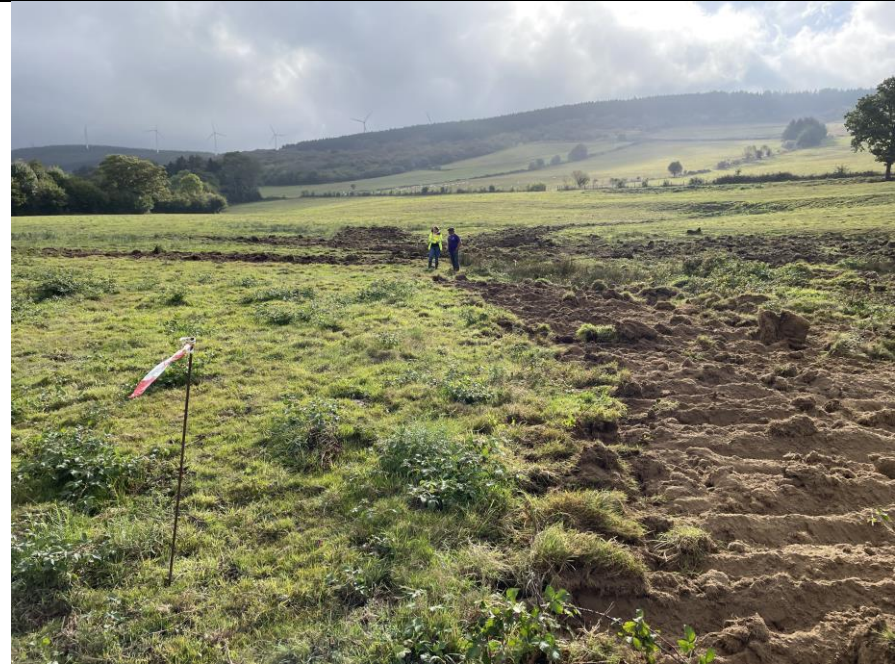
Piquetage des secteur où installer les ouvrages
