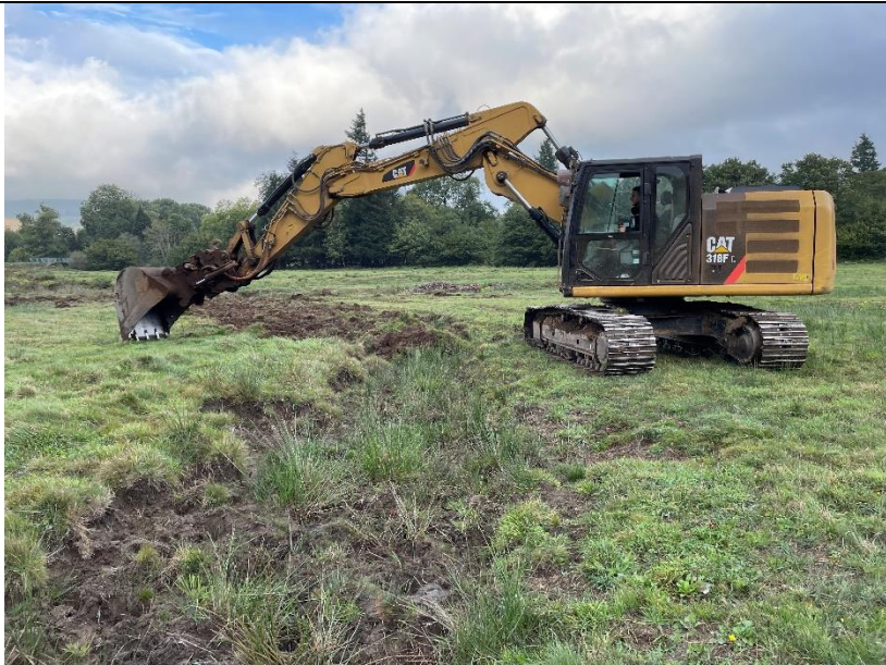
Comblement des fossés par tirage du bourrelet de terre initialement enlevée
