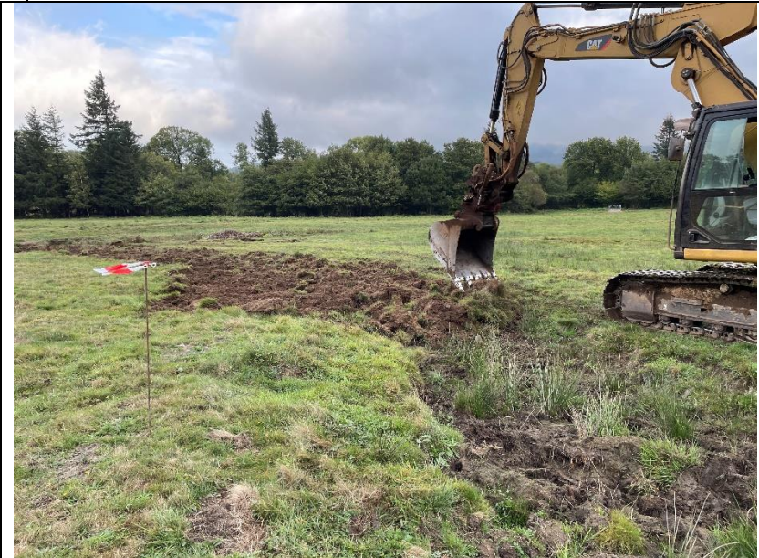
Comblement des fossés
