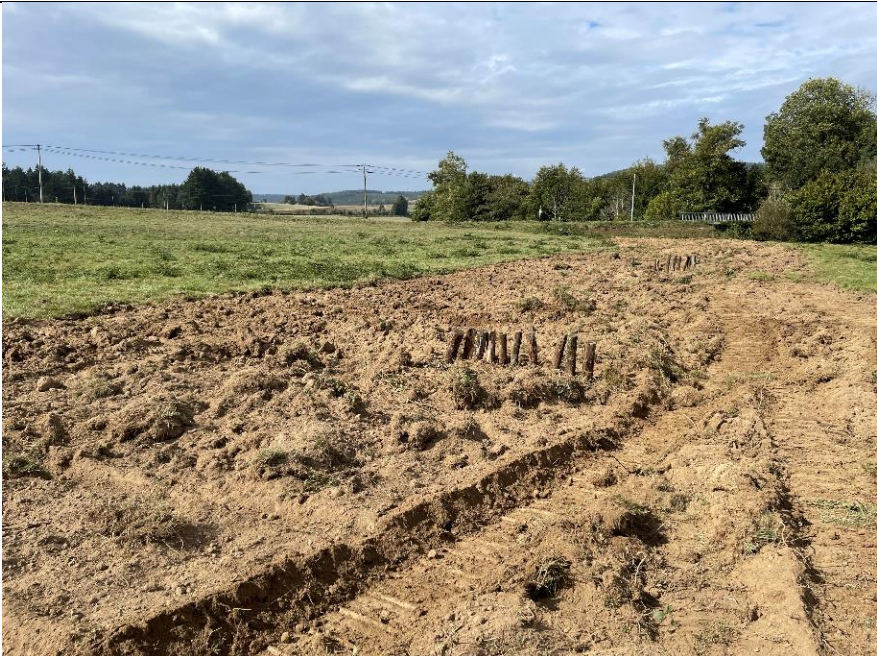
Vues des 3 ouvrages en enfilades installés pour freiner l'écoulement des eaux de surface
