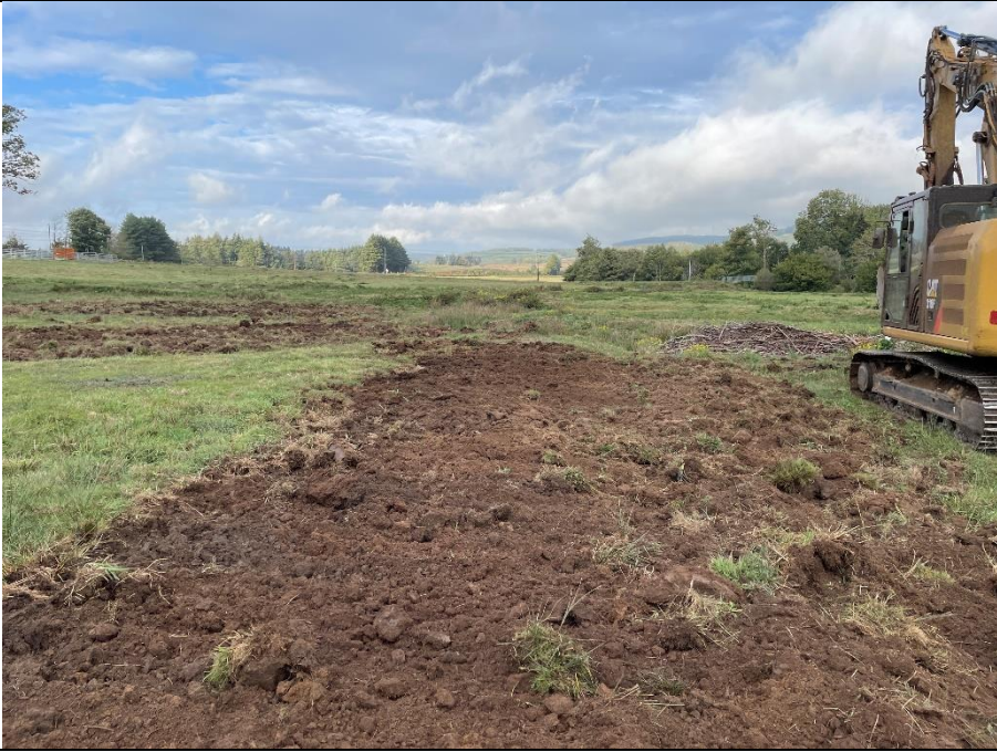
Egalisation de la surface
