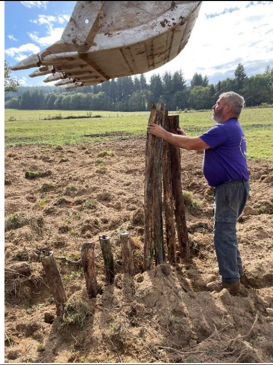
Insallation des pieux (2.5m) en chantaigner perpendiculairement au fossé comblé
