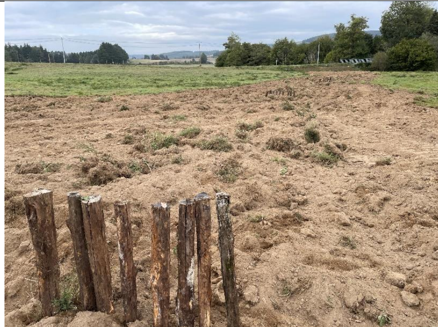
Insallation des pieux (2.5m) en chantaigner perpendiculairement au fossé comblé
