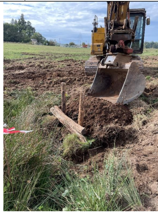
Installation d'un barrage afin de freiner les eaux de ruissellement de surface et maintenir une zone d'eau libre
